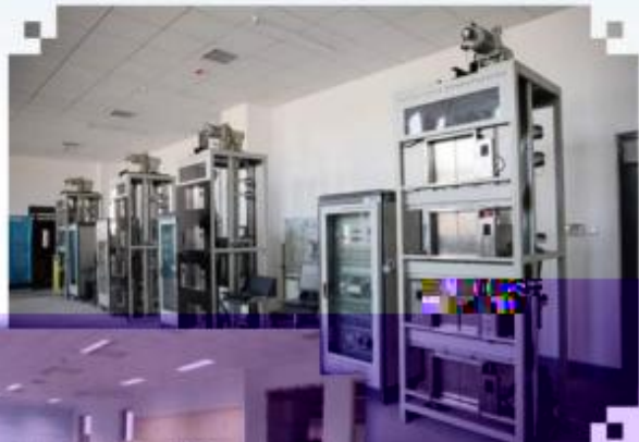
智能电梯安装调试 维护训练场所
